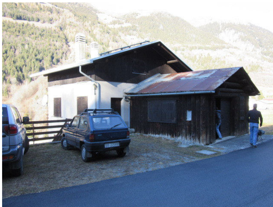
VISTA SUD EST DEL FABBRICATO
