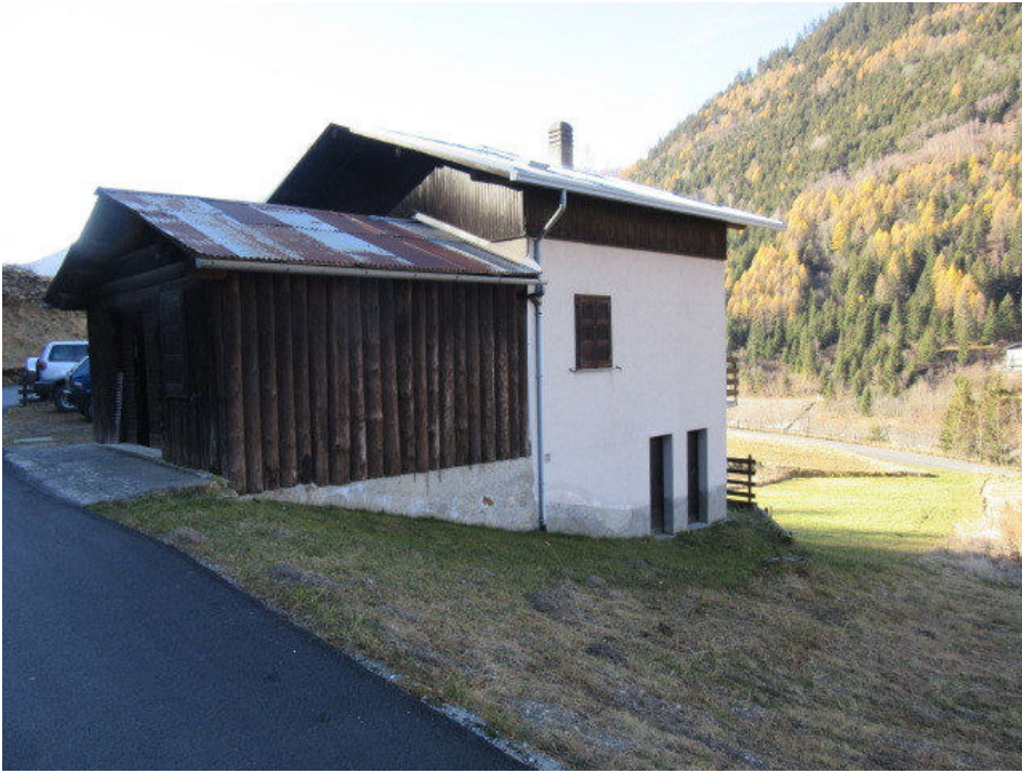
VISTA NORD EST DEL FABBRICATO
