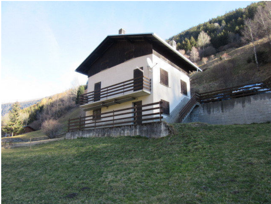
VISTA SUD OVEST DEL FABBRICATO
