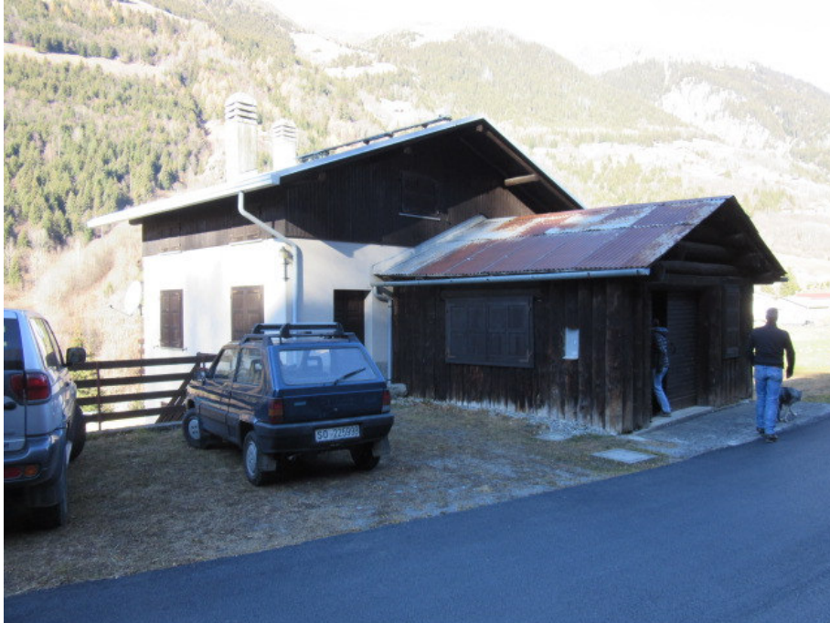
VISTA SUD EST DEL FABBRICATO
