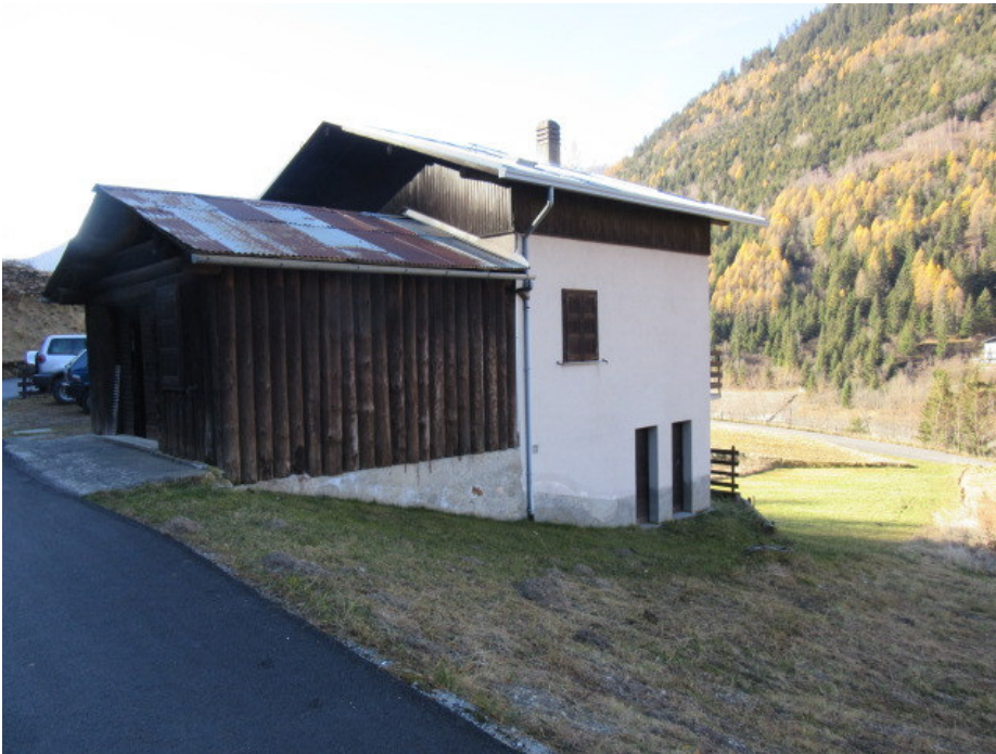
VISTA NORD EST DEL FABBRICATO
