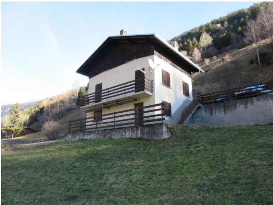
VISTA SUD OVEST DEL FABBRICATO
