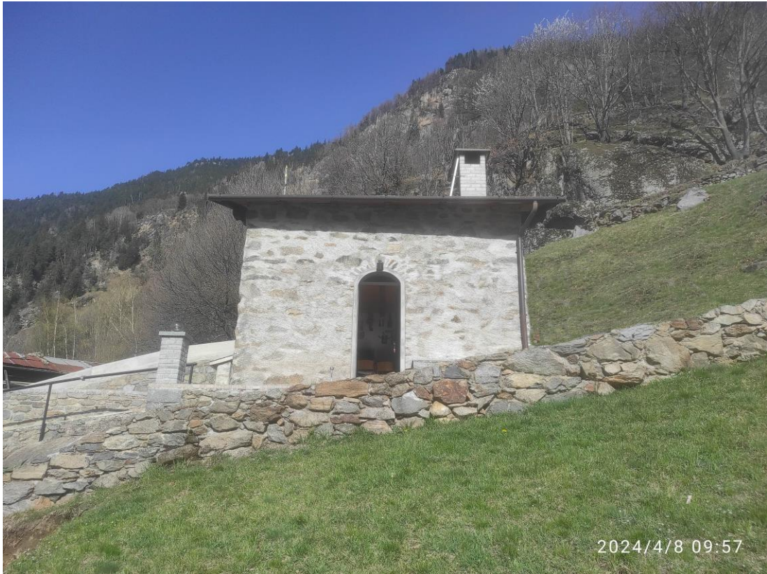
FOTO N.1: Vista est del fabbricato oggetto di intervento
