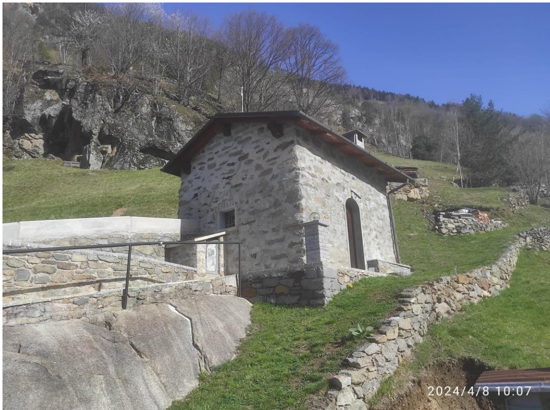
FOTO N.2: Vista sud-est fabbricato oggetto di intervento
